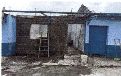
Foto1: Avance en sustitución de la lamina por lamina troquelada aluzinc en la cocina
