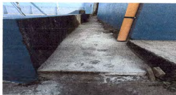
Foto 17 Se está trabajando en la reparación de la cuneta de concreto, a un costado del módulo de párvulos.
