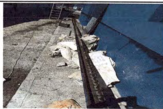
Foto 15 Se están realizando los trabajos de cambio de canal de metal, por canal galvanizado y bajadas de agua en el módulo de párvulos.
