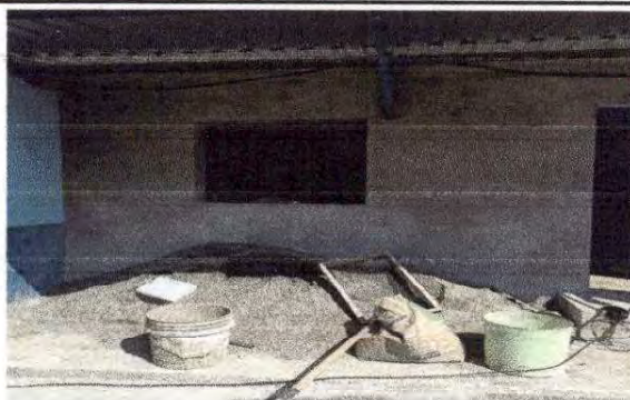
Foto 3: Se encuentra en proceso la estructura de metal de ventana y balcón de metal.
