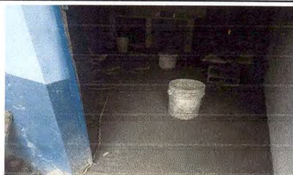
Foto 4: Se encuentra en reparación de piso para colocar piso ceramico. El piso ya no se encontraba en buenas condiciones.
