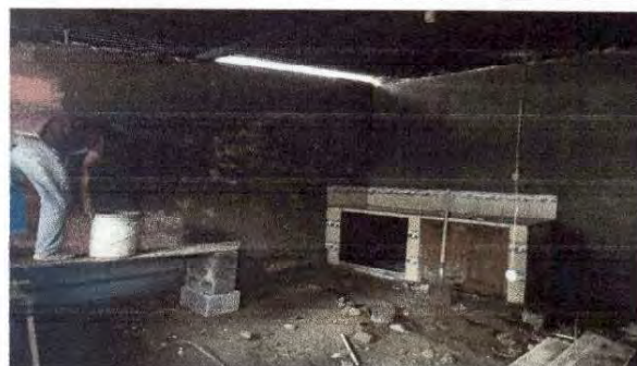
Foto 13 Se están repellando las paredes de los ambientes de la cocina y de la dirección.
