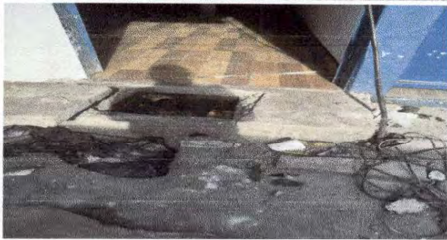
Foto 7 Se esta cambiando la caja de registro del drenaje en la entrada de la cocina.
