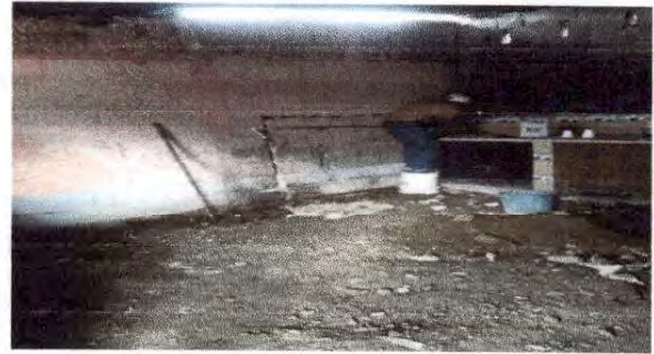
Foto 8 Se esta sustituyendo la tubería principal y se esta introduciendo en la pared en la cocina.
