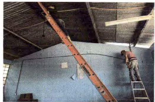
Foto 10 se trabaja en el cableado y accesorios electricos en aulas
