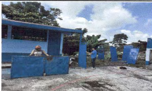
Foto 16 Se están realizando los trabajos de cambio de tubo, pintura y cambio de las chapas de puertas de varios ambientes.
