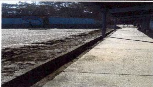
Foto 19. Se esta trabajando en la reparación de planchas de concreto en el patio de la escuela.
