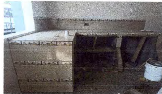
foto 12 se esta colocando el azulejo en gabinete de cocina
